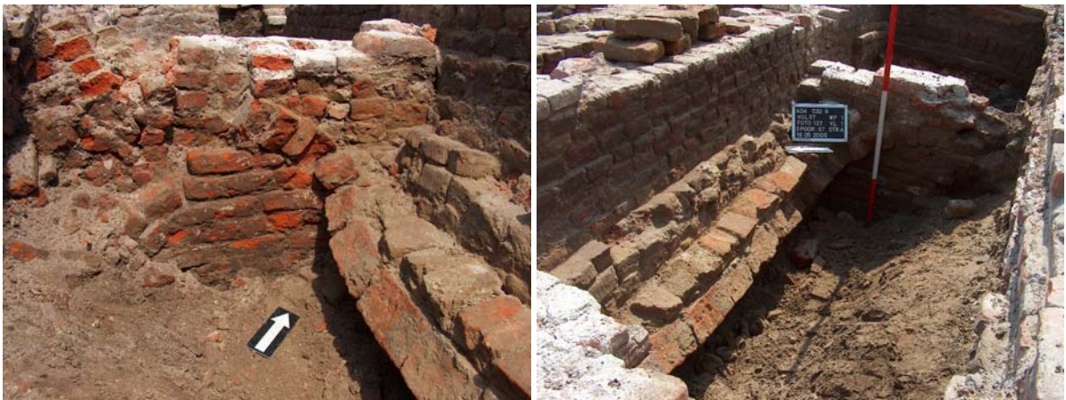
Afbeelding 4.45: detailfoto's van de opslagruimtes (S66, S67 en S68), aangetroffen onder het achterhuis van het pand Korte Nieuwstraat 13. Zichtbaar is de aanzet van enkele kleine gewelven.
