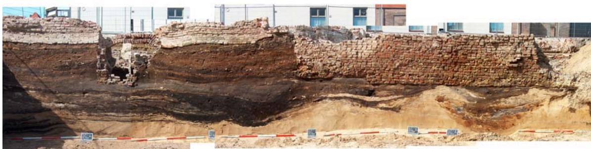
Afbeelding 4.35: S4, de oostelijke zijgevel van het pand Korte Nieuwstraat 13.
