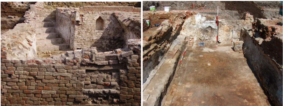
Afbeelding 4.44: overzichtsfoto van de gewelfde kelder S103, aangetroffen onder het achterhuis van het pand Korte Nieuwstraat 13, gezien vanuit het noorden en vanuit het zuiden.
