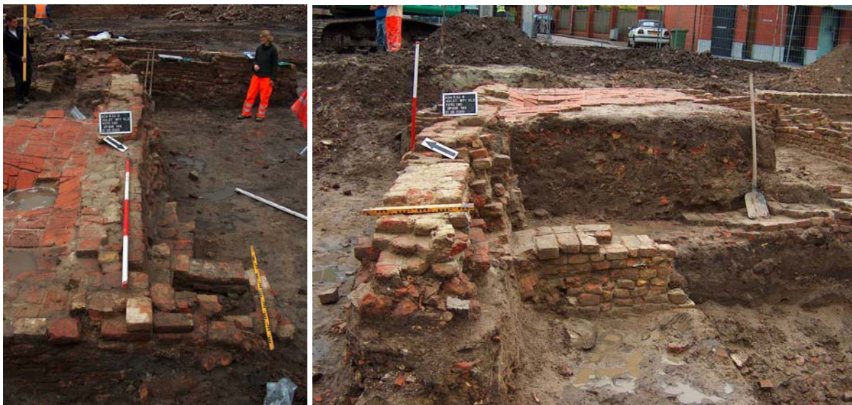
Afbeelding 4.66: detailfoto's van de achtergevel (S199) van de woning Korte Nieuwstraat 21 gezien vanuit het oosten en vanuit het westen.
