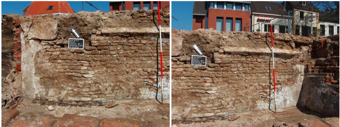
Afbeelding 4.88: de oostelijke zijgevel S34 van de kelder onder de woning Korte Nieuwstraat 19. Onder deze vloer werd nog een beerkelder (S368) aangetroffen.
