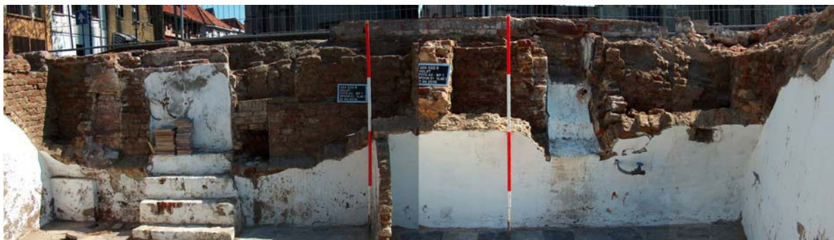
Afbeelding 4.72: gevelmuur S31 van de woning Korte Nieuwstraat 21.
